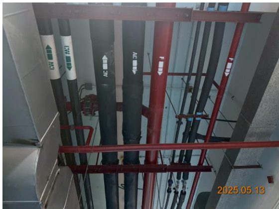
รูปที่ 3.1-26 การจัดระบบท่อประปาให้เป็นระเบียบ และแยกสีประเภทของน้ำ
