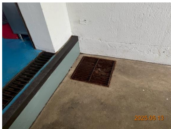
รูปที่ 2.12-21 ป่อพักน้ำรองรับน้ำชะขยะ
